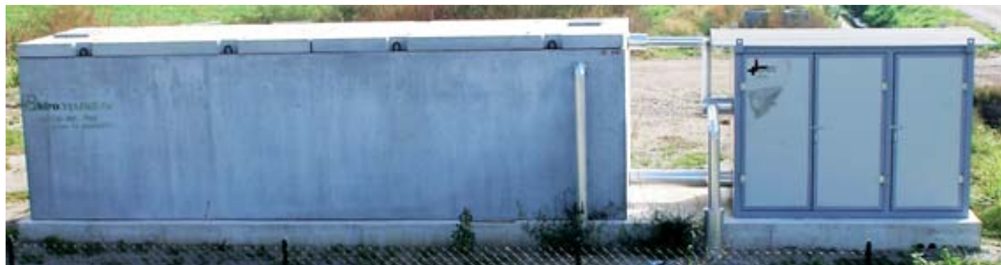
Esempio di installazione sottobattente fuori terra
